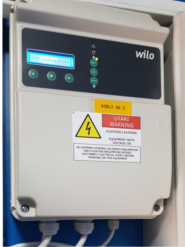
Dalgıç Pompalarının Akıllı Kontrol Panoları
