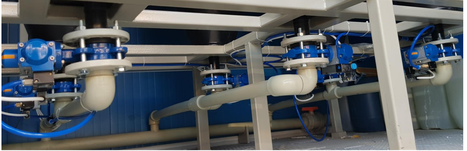
Rehabilitate Sistem Pnomatik Kelebek Vanalar
