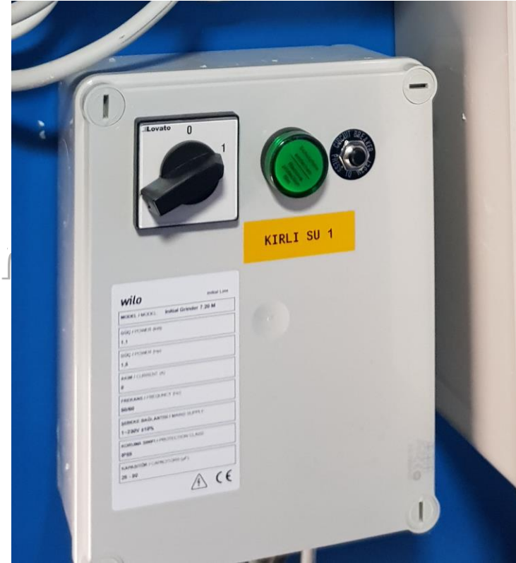
Dalgıç Pompalarının Akıllı Kontrol Panoları
