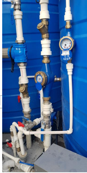
Yağmur suyu, Şebeke Giriş ve WC Çıkış Sayaçları
